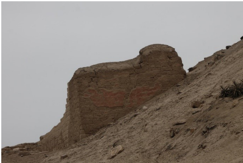
Imagen 28. Vestigio de pintura mural en la zona lateral izquierda del Templo (Herrera 2018).
